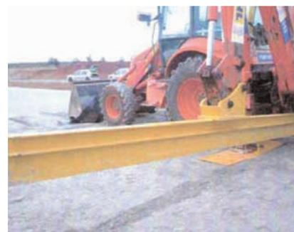
La prefisuración se ejecuta tras el extendido y antes de ejercer ningún tipo de compactación en la capa (excepto la precompactación de la extendedora).
