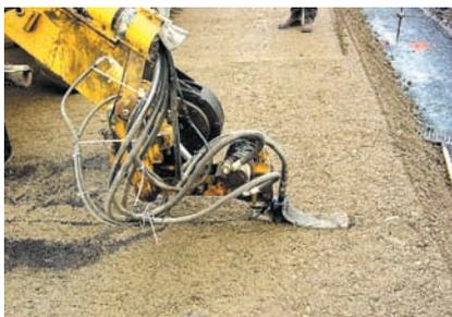
Se trata de un equipo que, al mismo tiempo que realiza la entalla, vierte emulsión en las paredes de la misma. Estas operaciones se llevan a cabo de forma automática mediante un sistema electrónico programable.
