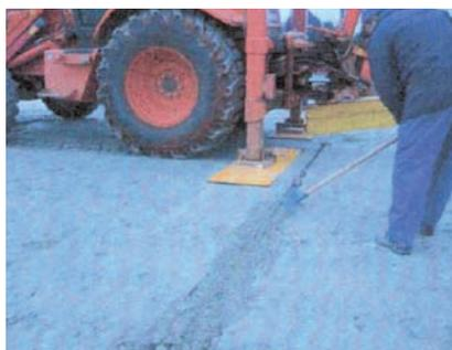
El aspecto de la capa terminada es, en general, bueno, pero presenta ondulaciones que parecen coincidir en los puntos altos con las juntas de prefisuración. Esta apreciación es
