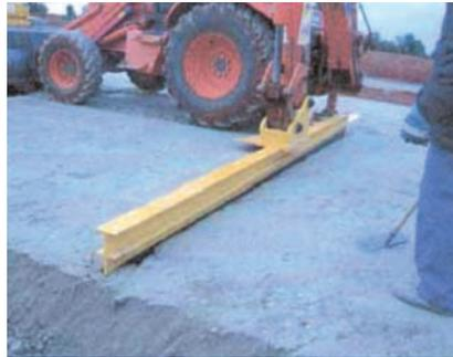
Una vez ejecutada la fisura, un operario receba la parte superior de la junta con la rastrilla, con el fin de dejar una superficie homogénea y regular. Esta acción, además de aportar material, consigue que el efecto de la ondulación en la zona de la fisura se reduzca.
