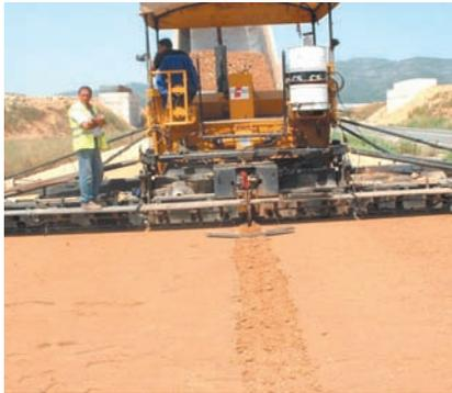
La ejecución de la fisura, dado que el perfil tiene la mitad de longitud que el ancho de la capa, se ejecuta en dos fases. Primero, se ejecuta un margen y, con un giro de 180° del brazo de la máquina, se ejecuta la otra margen. De esta forma, se evita que la excavadora tenga que realizar movimientos sobre la capa de suelocemento antes de compactar.
