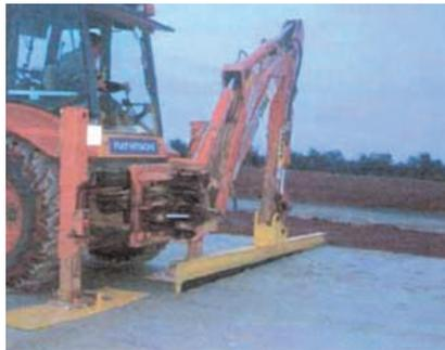
El sistema de prefisuración es rápido y no entorpece el ritmo de ejecución del suelo cemento. El ritmo de ejecución de las fisuras está marcado por el ritmo de avance de la extendedora. El rendimiento medio de la extensión de suelocemento fue de unos 500 m diarios de media.
