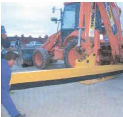
Para permitir la penetración completa del perfil hasta el tope, en algunos casos debe realizarse un movimiento similar al corte con un cuchillo, que la maquinaria permite ya que la herramienta está unida al brazo del mismo modo que el cazo de la excavadora.
