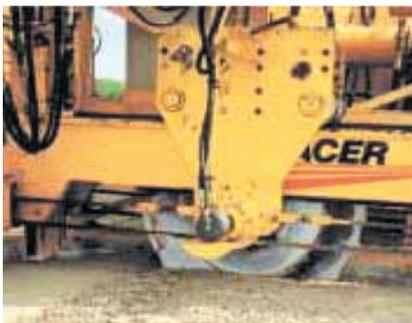
Una herramienta para el cierre del surco es actualmente llevada por un tractor. Este instrumento está constituido por dos peines que, colocados de una y otra parte de la junta y animados de un movimiento alternativo, acaban de cerrar el surco aplicando el material contra el de la junta. El tractor asegura el transporte de la herramienta, su posición y el movimiento alternativo de los peines.
