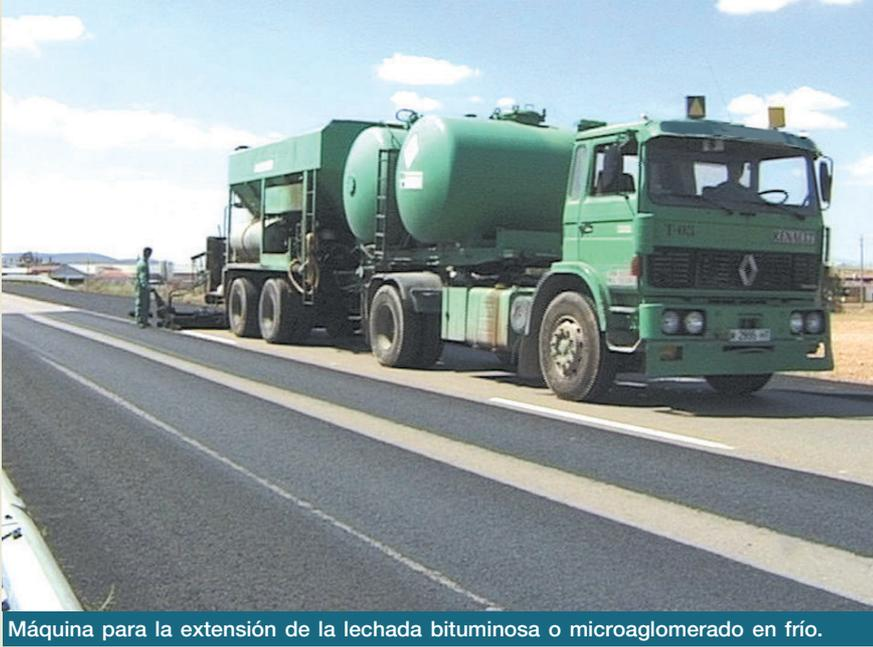
Máquina para la extensión de la lechada bituminosa o microaglomerado en frío.
