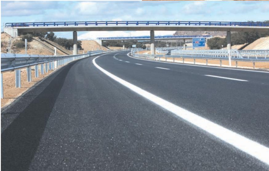
El tronco de la autovía ha sido diseñado para una velocidad de 100 km/h, y a lo largo de su recorrido se han dispuesto 2 enlaces, 3 estructuras en el tronco, 5 pasos inferiores y 6 pasos superiores.
