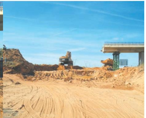
3. Demolición de los estribos existentes.
