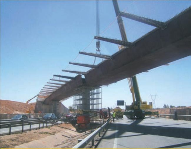
Montaje del cajón metálico.
