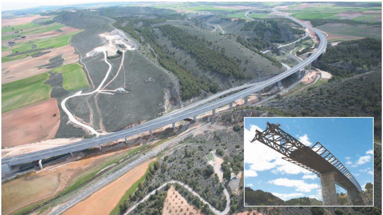
La foto de fondo corresponde a una vista aérea del viaducto de Paredes. Abajo, a la derecha, foto realizada durante el lanzamiento del viaducto 2 del Estrecho de Paredes. Viaducto mixto sobre ábacos metálicos. Vista de nariz de lanzamiento.
