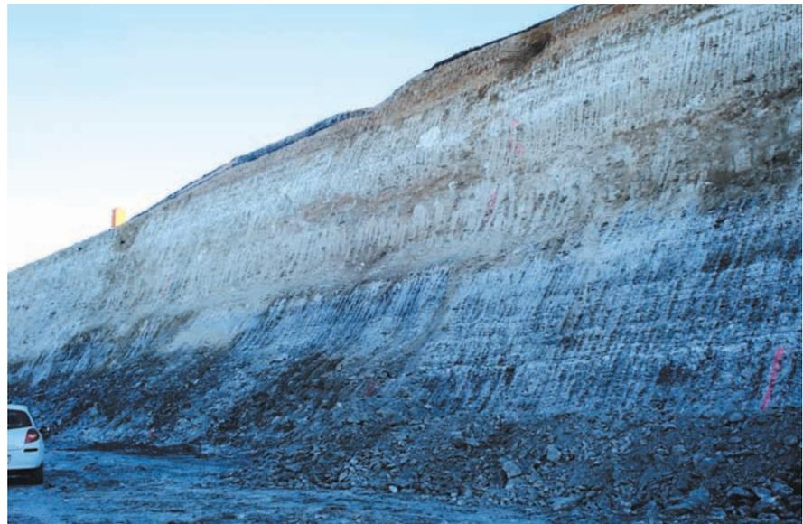
Desmorte en materiales yesíferos. Se aprecia la granulometría de todo uno del material en el pie del talud
