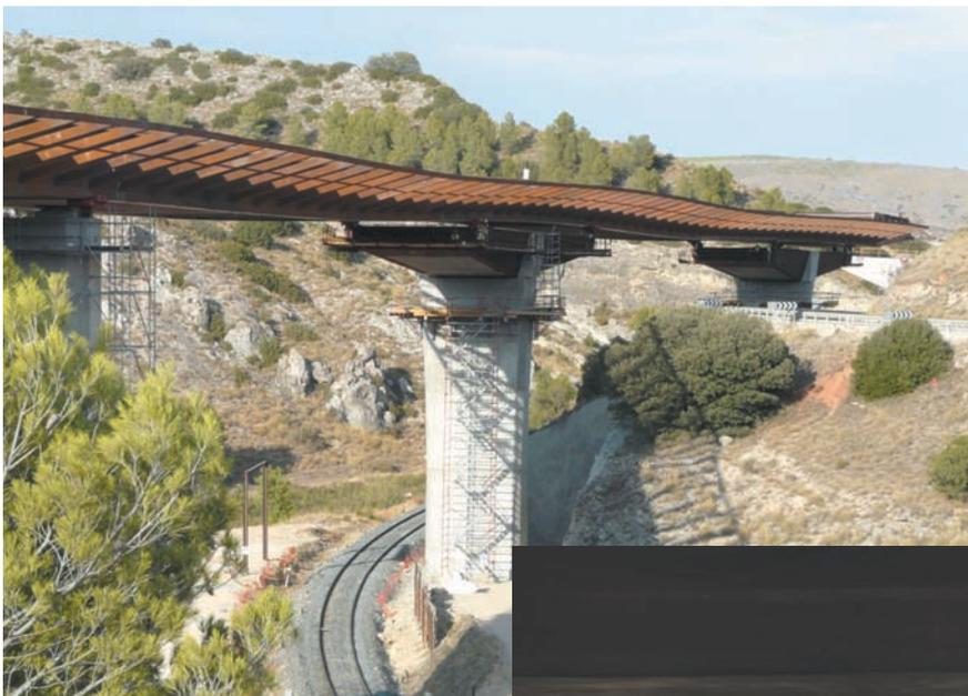
Foto superior: Vista de ábacos metálicos durante el lanzamiento del viaducto 2 del Estrecho de Paredes.
