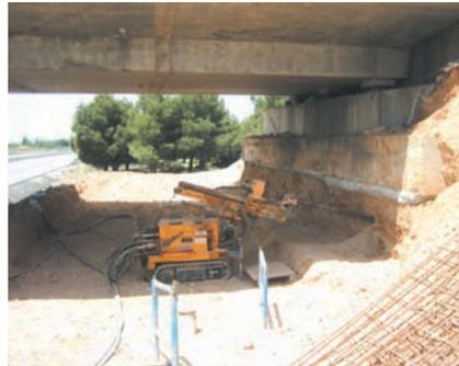
1. Ejecución de muros de soil nailing bajo estribos existentes.
