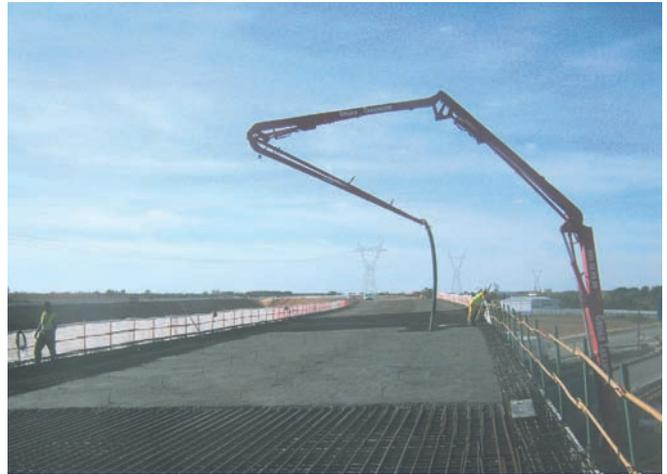
Homigonado, del tablero una vez colocadas las prelosas y la ferralla.
