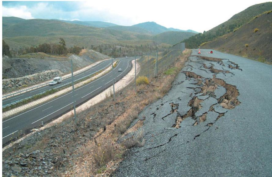
Autovía A-92. Tramo Huéneja-Las Juntas, km 350. Deslizamiento a mitad de la altura en talud en esquistos meteorizados y replegados.
