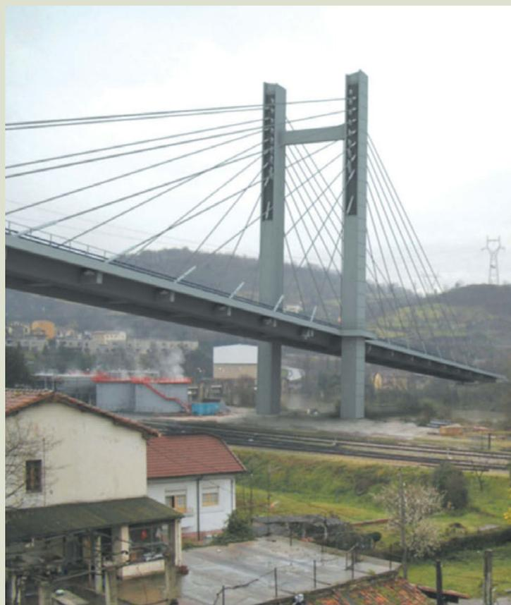
Fotomontaje de un viaducto sobre el río Caudal y las vías FEVE, de tipo atirantado, en los nuevos accesos a Soto de Ribera.
