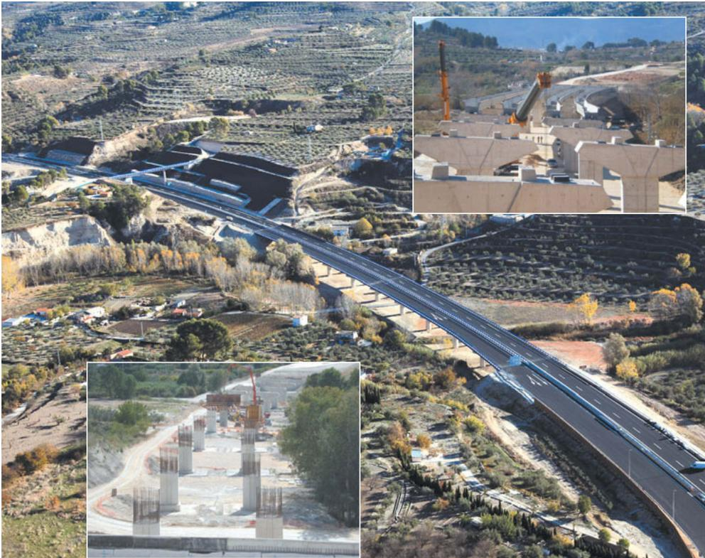
Viaducto de Perera y detalles de su fase de construcción: montaje de vigas y dinteles.
