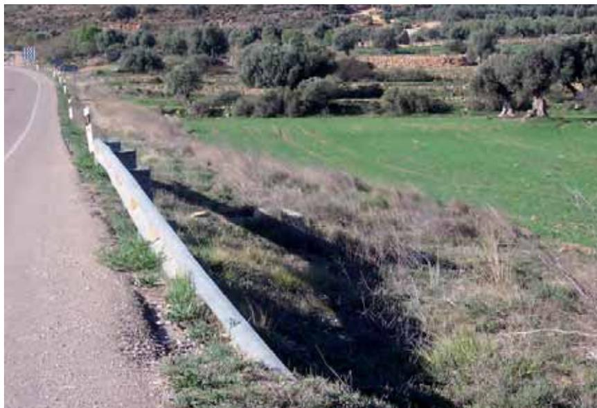
Figura 6. Indicador de barrera = 3: Existencia de barrera cuya disposición no se ajusta a los criterios de las Recomendaciones sobre sistemas de contención de vehículos.
