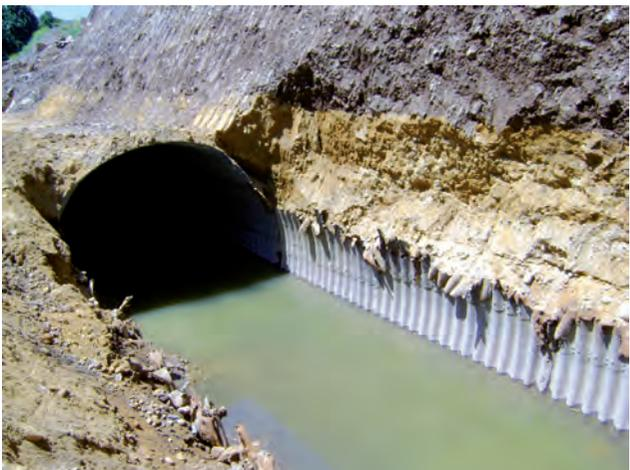
Foto 30. Desmontaje de tubo
