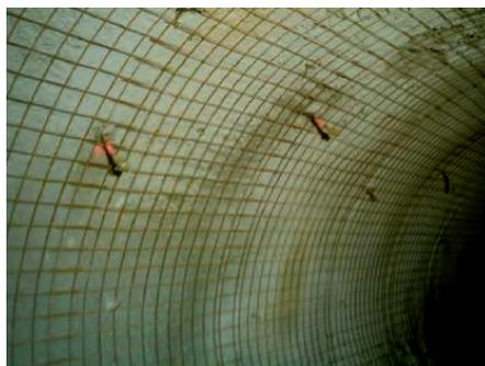
Foto 25. Colocación malla electrosoldada
