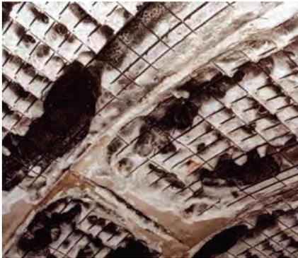
Figura 8. Daños por "spalling" en las dovelas del túnel de la Mancha después del incendio de 1996
