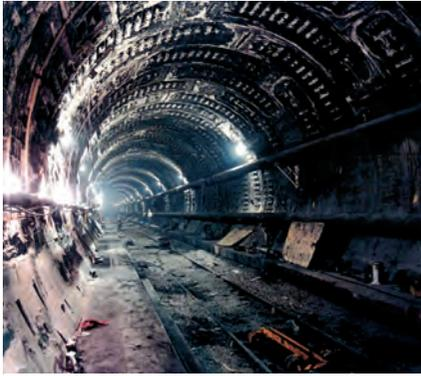
Figura 7. Daños en las dovelas del túnel de La Mancha después del incendio de 1996
