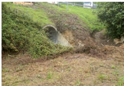
Foto 17. Obras sin canalización a pie de talud
