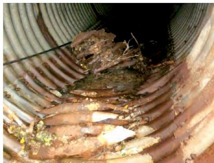
Foto 5. Deformaciones y corrosión
