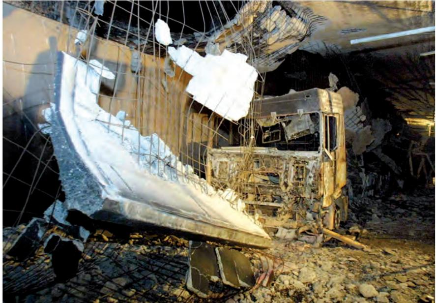
Figura 5. Elementos de la infraestructura del túnel de San Gotardo caídos después del incendio de 2001
