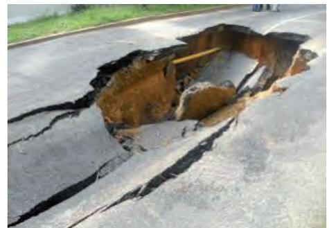
Foto 6. Colapso y hundimiento calzada
