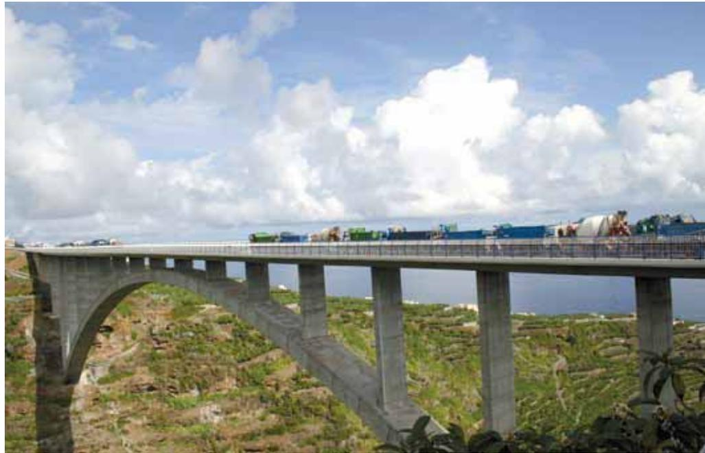
Prueba de carga en el puente de Los Tilos
