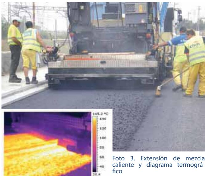
Foto 3. Extensión de mezcla caliente y diagrama termográfico
