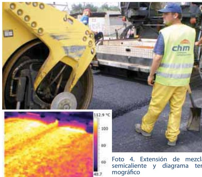
Foto 4. Extensión de mezcla semicaliente y diagrama termográfico
