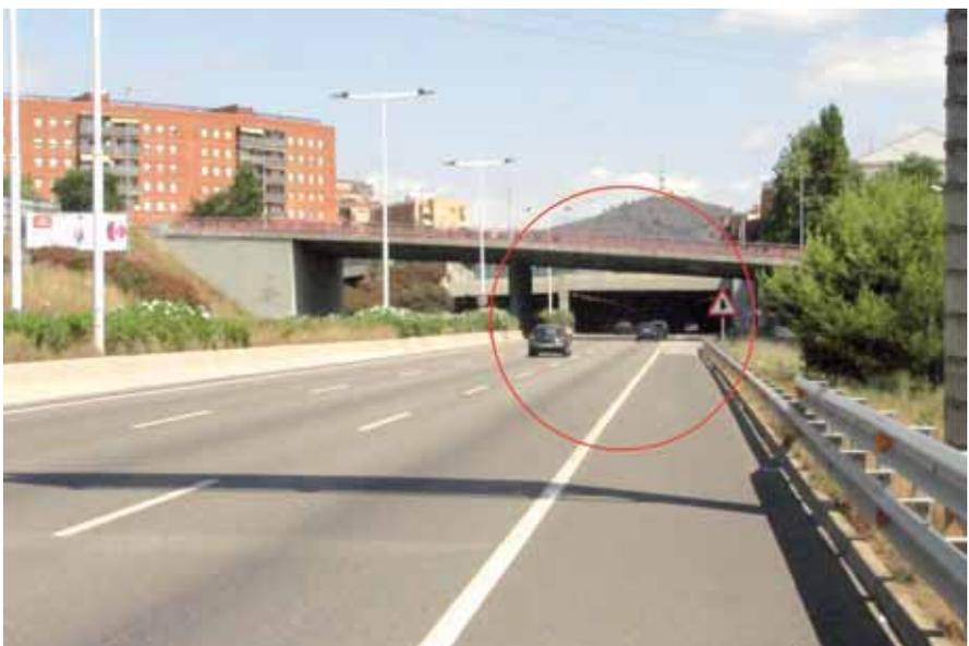
Figura 8. Cono visión 20° a escala de la boca de entrada Este del túnel de B
