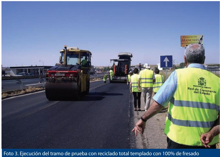
Foto 3. Ejecución del tramo de prueba con reciclado total templado con 100% de fresado
