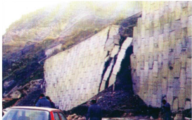
Figura 30. Ruina de un muro de tierra armada en la bajada de Granada a Motril (Lluvias de 1997).
