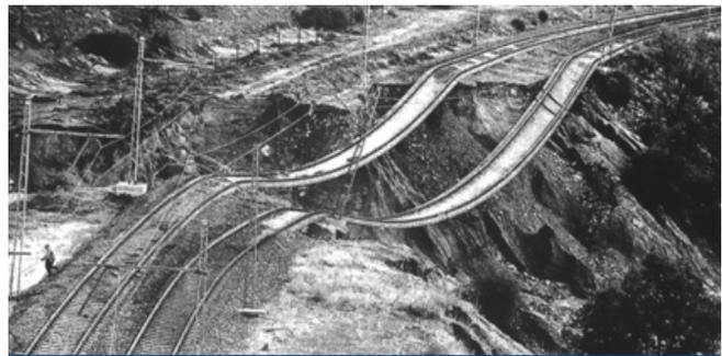
Figura 28. Deslizamiento de un terraplén sobre "margas del Guadalquivir" en Almodóvar del Río (ABC).
