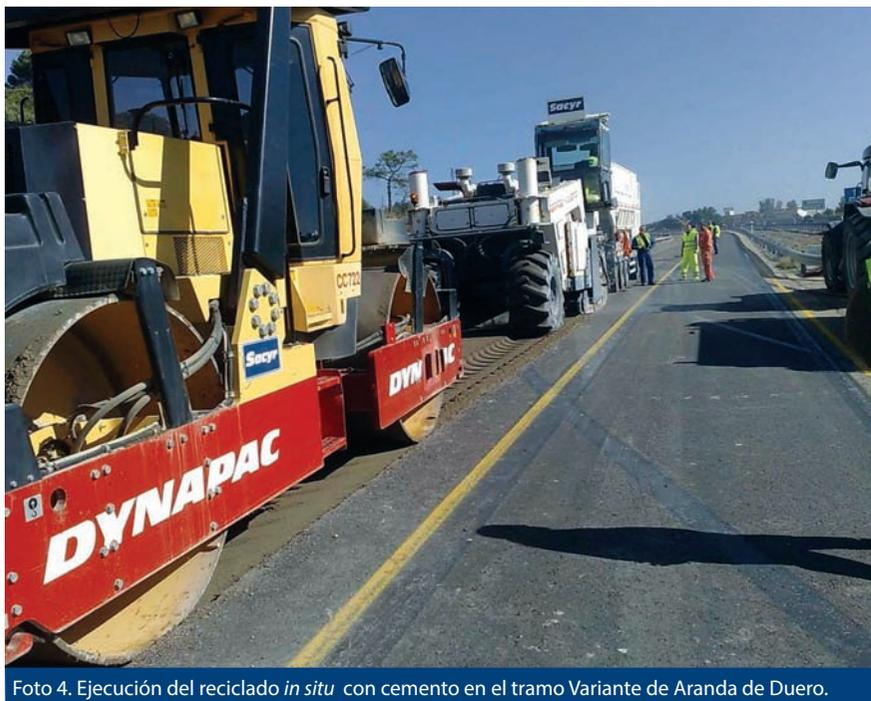
Foto 4. Ejecución del reciclado *in situ* con cemento en el tramo Variante de Aranda de Duero.
