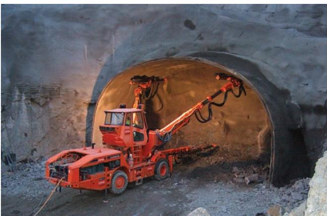
Figura 6. Jumbo perforando túnel de Berroy.
