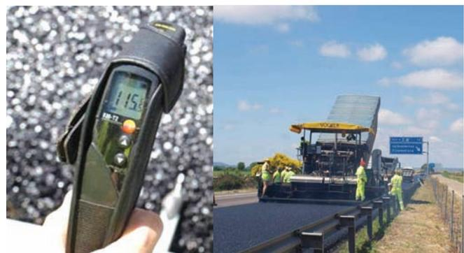
Figura 8. Autopista A 62 (Palencia). Detalle del extendido de la mezcla.
