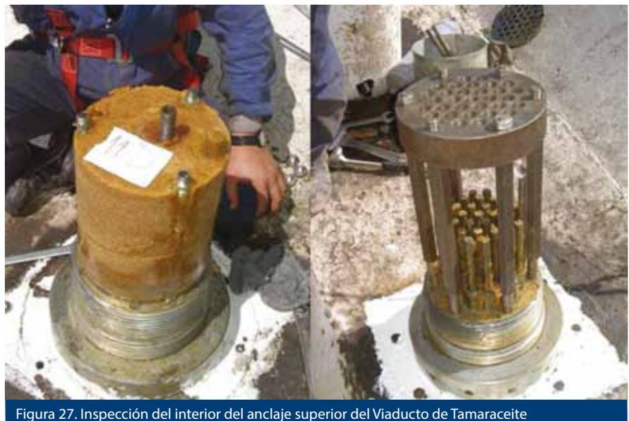
Figura 27. Inspección del interior del anclaje superior del Viaducto de Tamaraceite
