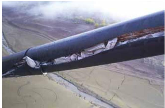
Figura 10. Filtración de agua, expansión de lechada, rotura de vaina y corrosión de los cordones
