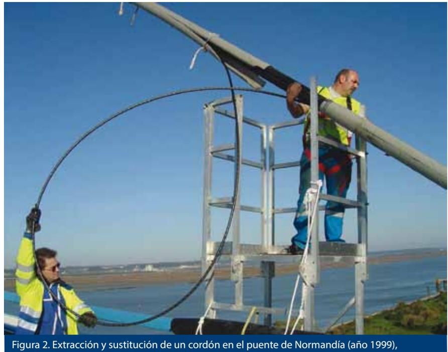
Figura 2. Extracción y sustitución de un cordón en el puente de Normandía (año 1999),
