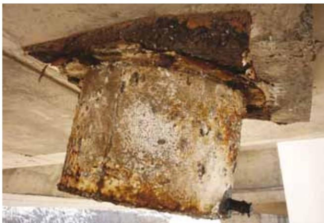
Figura 3. Corrosión en el exterior del capot
