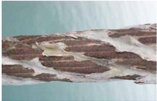
Figura 8. Protección contra la corrosión dañada. Péndolas del puente de las Américas . Panamá
