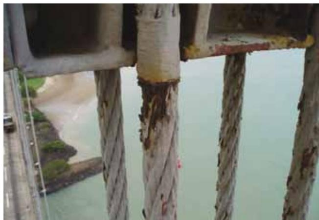
Figura 12. Corrosión y reducción de sección por resqueijo y roce
