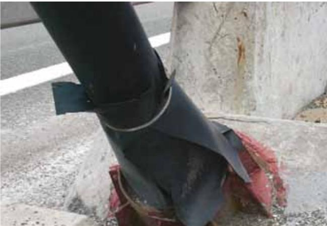
Figura 7. Daños en faldón de conexión entre vaina y tubo guía
