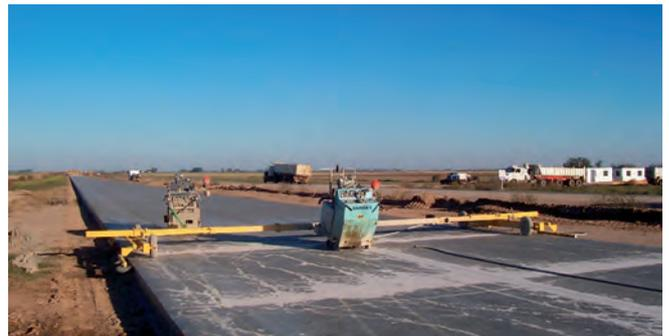
Figura 26. Dispositivo guía para el serrado longitudinal, que evita la realización de replanteos topográficos y errores humanos.
