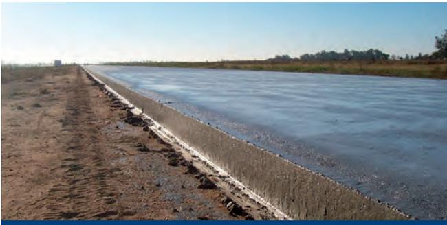
Figura 23. Vista del borde de la calzada terminada. Se observa que mantiene una perfecta verticalidad, lo que indica que se ha utilizado una consistencia adecuada en la mezcla. Un hormigón con un asentamiento menor al requerido, hubiera dificultado la correcta terminación superficial con la aparición de "nidos de abeja". En cambio, si el asentamiento hubiera sido superior al necesario, se hubieran producido caída de los bordes, lo que requeriría el encofrado de los mismos.
