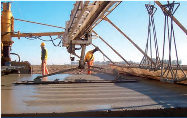
Figura 19. Vista del fratás oscilante (regla *auto float*), responsable de reparar y mejorar la lisura de la calzada. Este dispositivo se desplaza de manera oscilante y en sentido transversal al avance de la pavimentadora.
