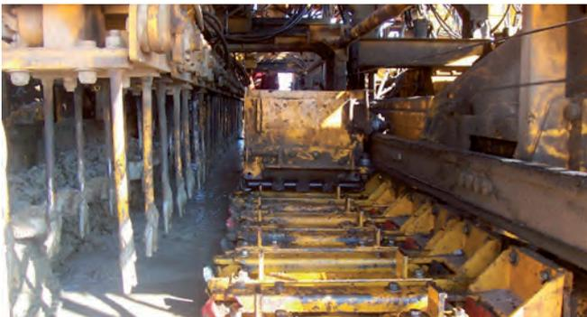
Figura 13. Vista del carro distribuidor de pasadores desplazándose transversalmente al sentido de avance de la pavimentadora, dejando un pasador en cada cuna.
