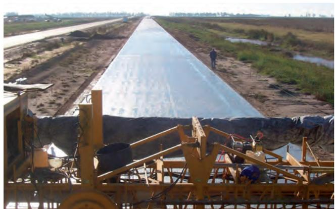
Figura 22. Vista desde el tren de curado de la superficie de la calzada terminada.
