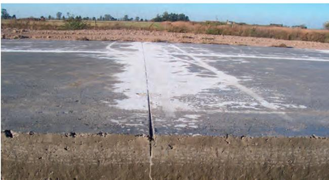
Figura 27. Vista de una junta transversal de contracción serrada, que provoca un plano de debilitamiento que provoca la fisura en la secuencia deseada.
