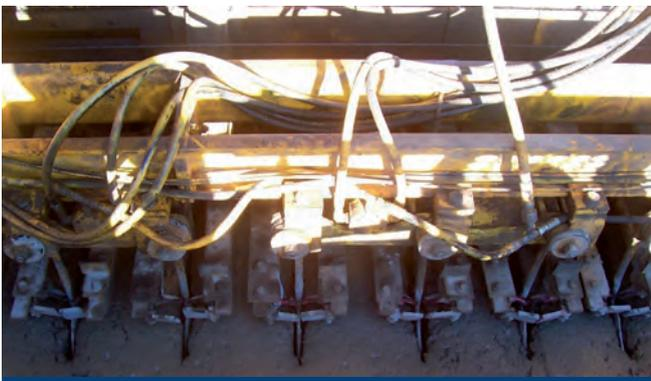
Figura 15. Vista superior de las horquillas, al momento de insertar los pasadores. En este momento el bastidor queda inmóvil sobre la superficie del hormigón, mientras la pavimentadora continúa su avance. La inserción se realiza a la distancia previamente programada en el equipo pavimentador, igual a la separación entre juntas transversales de contracción.
