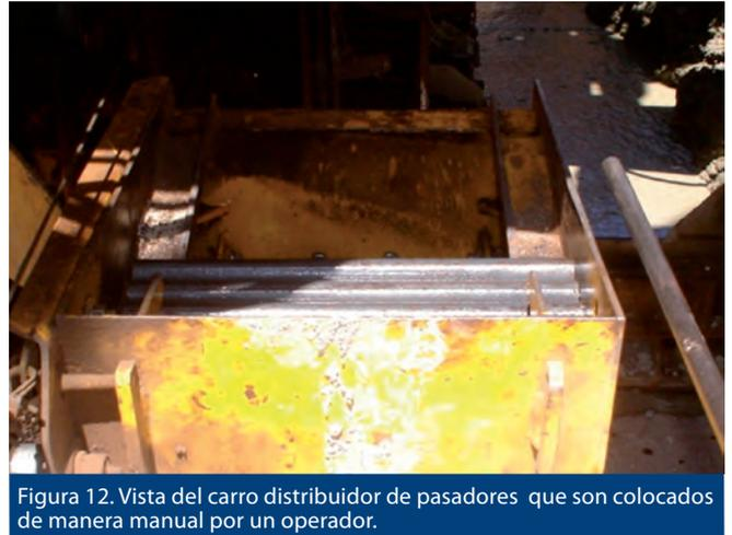
Figura 12. Vista del carro distribuidor de pasadores que son colocados de manera manual por un operador.
