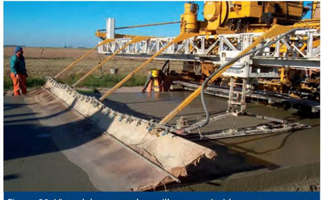
Figura 20. Vista del arrastre de arpillera constituida por tres o cuatro capas de tela de saco, cuya misión es eliminar las pequeñas marcas del fratás oscilante y obtener la microtextura de la superficie. El dispositivo sostiene picos regadores que mantienen la humedad en la arpillera.
