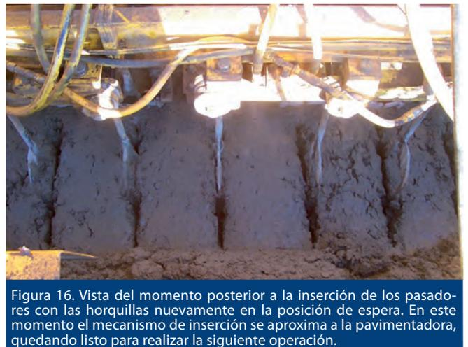
Figura 16. Vista del momento posterior a la inserción de los pasadores con las horquillas nuevamente en la posición de espera. En este momento el mecanismo de inserción se aproxima a la pavimentadora, quedando listo para realizar la siguiente operación.
