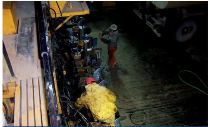
Figura 24. Terminada la jornada de trabajo, el equipo pavimentador debe ser completamente revisado y abastecido, para que quede en disposición de comenzar el trabajo el día siguiente.
