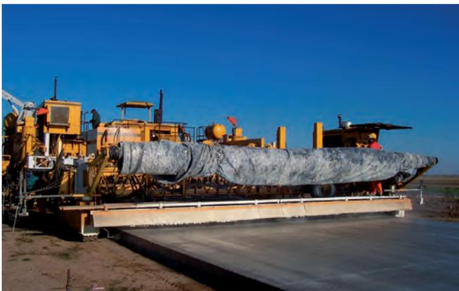
Figura 21. Vista del dispositivo aplicador de membrana de polietileno, que se utiliza exclusivamente en el caso que comience una lluvia imprevista, con el fin de que el agua precipitada no dañe la superficie.
