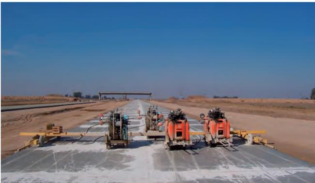
Figura 25. Vista de los equipos de serrado (máquinas de corte con discos de diamante). Es indispensable contar con equipos en exceso para evitar problemas de fisuración no controlada en el caso de rotura de alguno de ellos.
