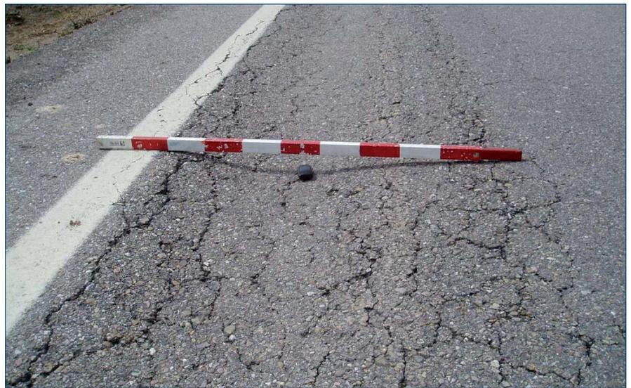
Figura 4. Hundimiento de la rodada
