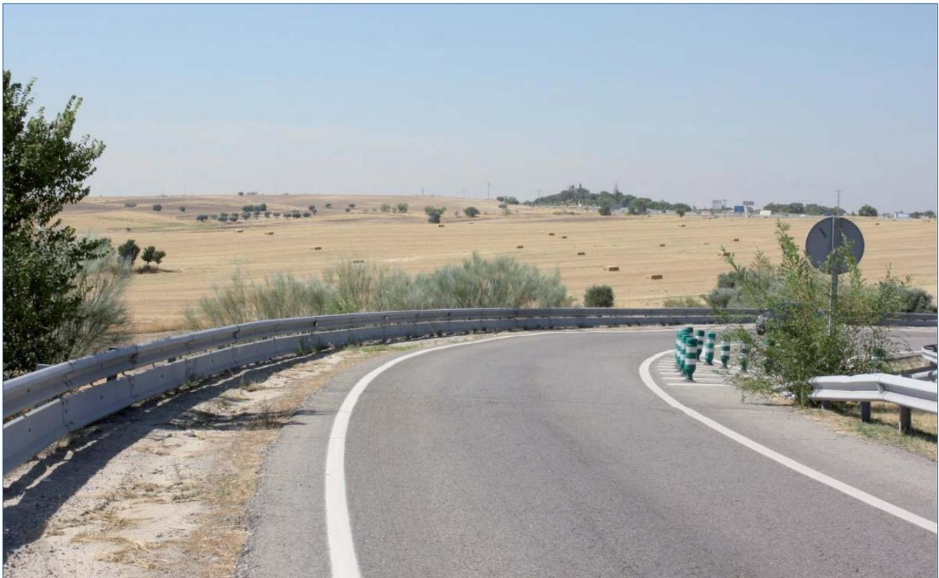
Figura 7. Barrera de seguridad con dispositivos de protección de motoristas
