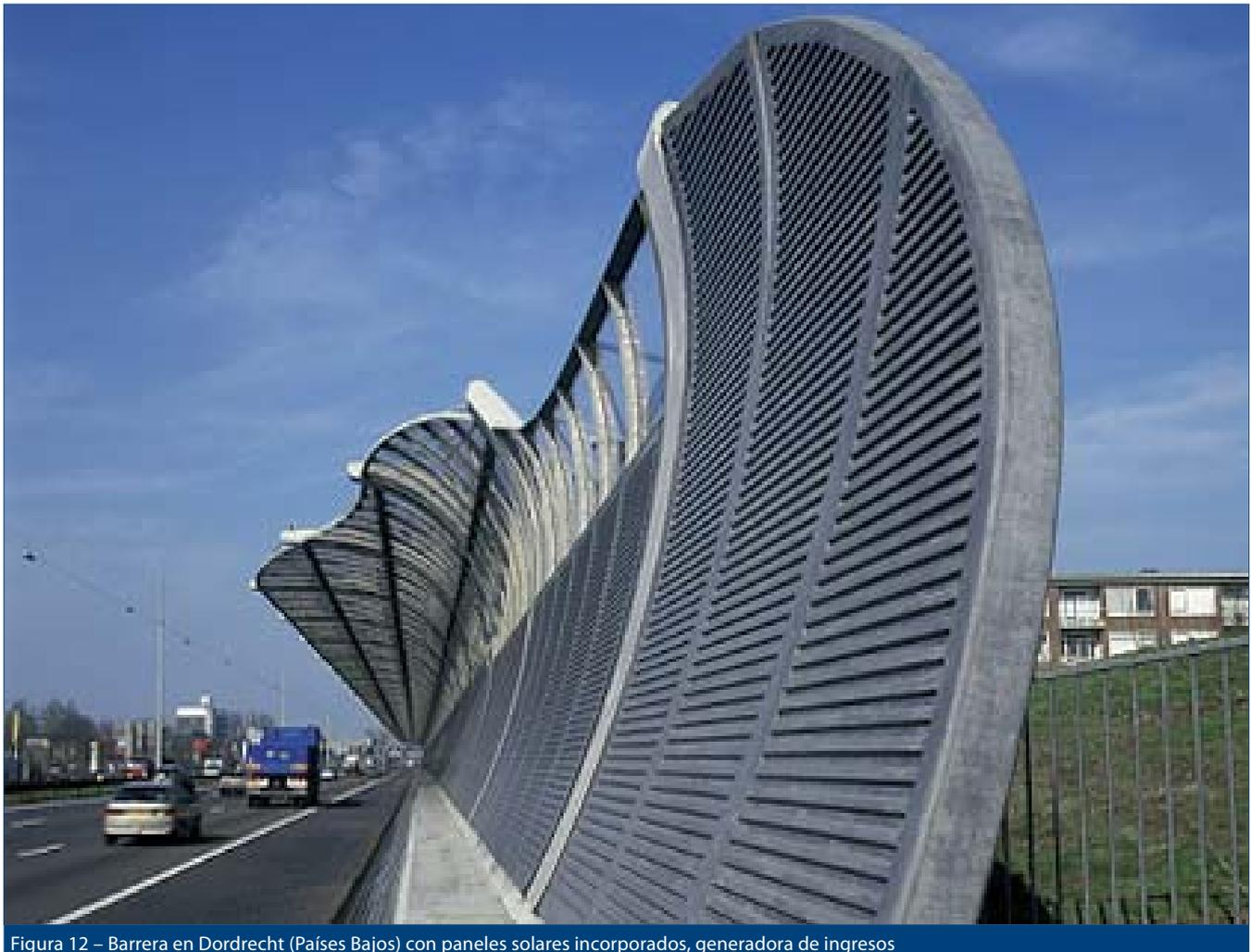
Figura 12 – Barrera en Dordrecht (Países Bajos) con paneles solares incorporados, generadora de ingresos
