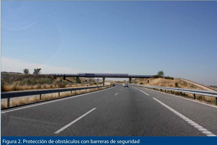
Figura 2. Protección de obstáculos con barreras de seguridad
