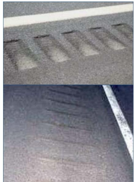
Figura 3. Bandas sonoras fresadas y moldeadas
