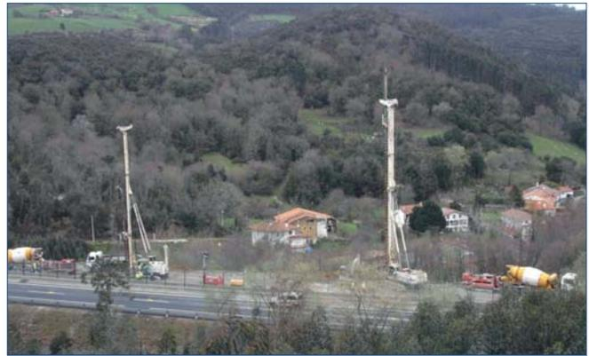
Figura 8. Vista general del tratamiento mediante pilotes de mortero
