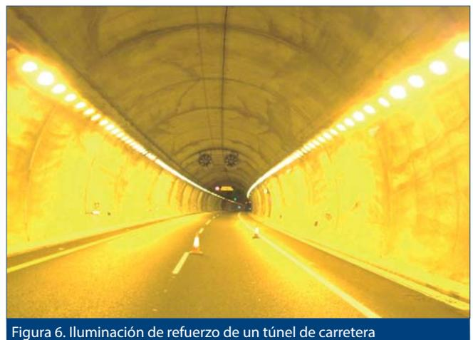
Figura 6. Iluminación de refuerzo de un túnel de carretera
