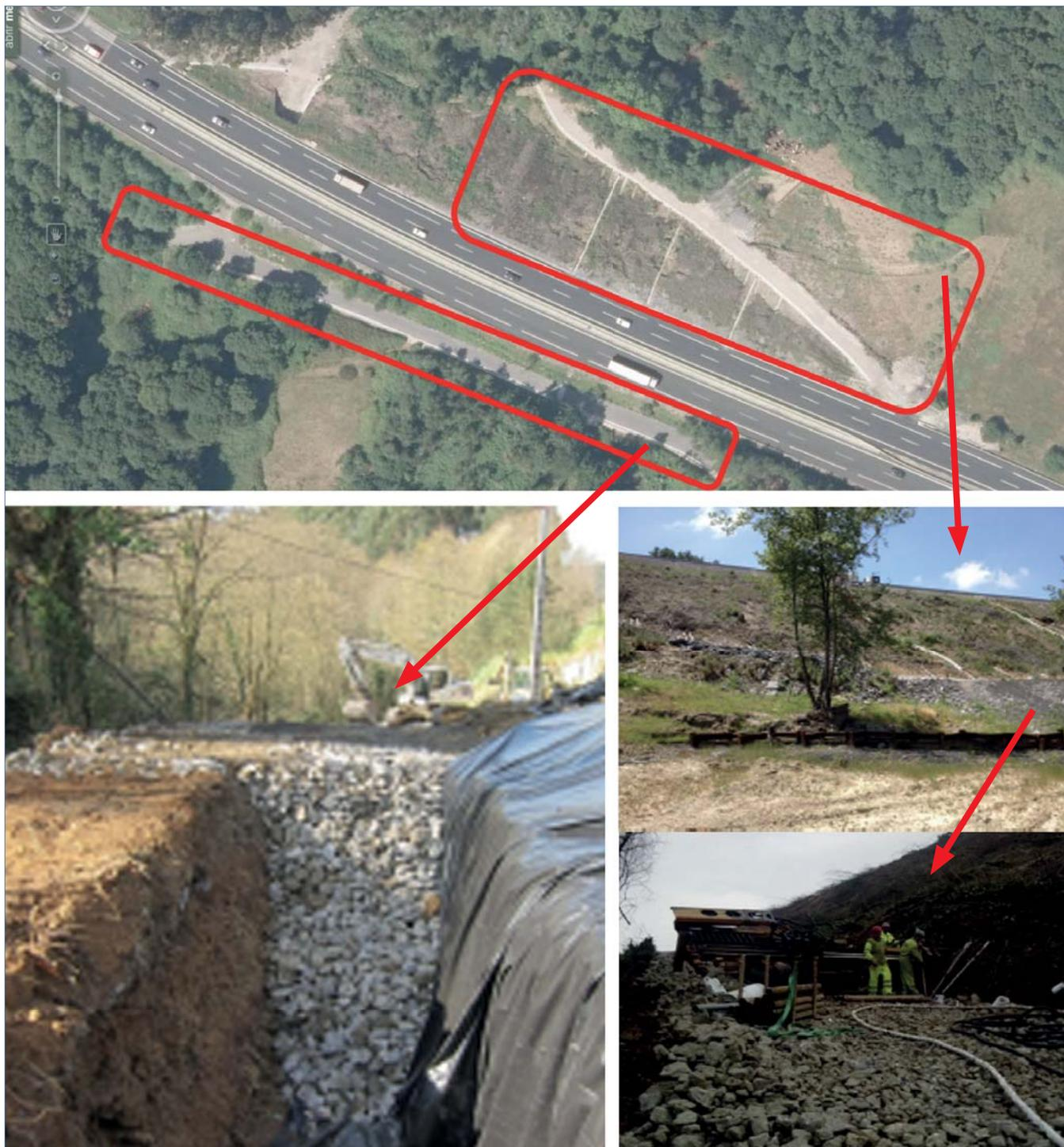
Figura 15. Esquema fotográfico de la Estabilización de terraplén en Liendo del PK 167 de la Autovía A-8 en Liendo (Cantabria)
