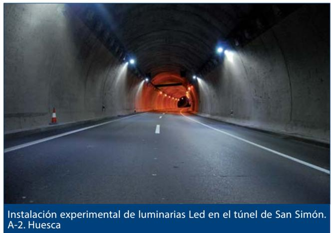
Instalación experimental de luminarias Led en el túnel de San Simón. A-2. Huesca
