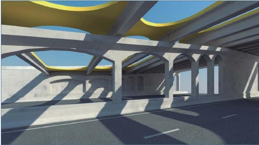
TYPSA llevó a cabo un detallado estudio de tipologías, en el que los gálibos normativos y los reducidos radios de las directrices de los tableros fueron condicionantes clave. Finalmente se optó por una tipología tipo pérgola que, gracias a su pequeño canto, facilitó el encaje del trazado en planta y alzado de los ramales en retorno.
