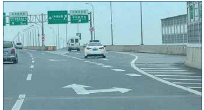
Figura 7. Marca vial de separación de carril de deceleración sin discontinuidad (Shanghái, China)
