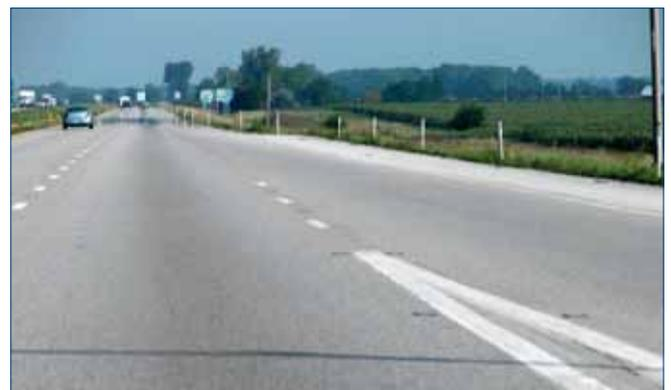
Figura 9. Marca vial de separación de carril de aceleración con discontinuidad en I-65 (Lafayette, Indiana, EE. UU.)
