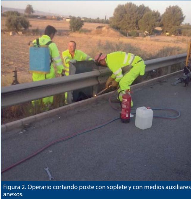
Figura 2. Operario cortando poste con soplete y con medios auxiliares anexos.
