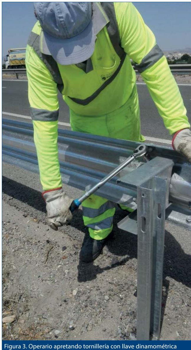
Figura 3. Operario apretando tornillería con llave dinamométrica
