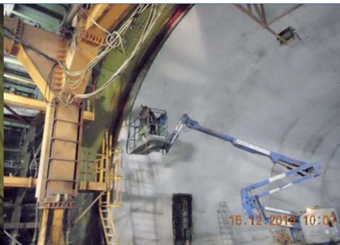
Figuras 13 y 14. Colocación de tubos embebidos hasta la clave en el canto de la junta entre puestas del revestimiento. Túnel de Caldearenas en la A-23
