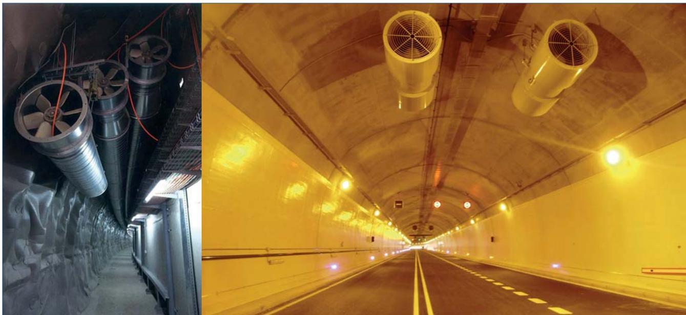
Figura 9. Ventiladores en galería de evacuación en el túnel de Rañadoiro y a la derecha ventiladores en el túnel de Petralba (N-260)
