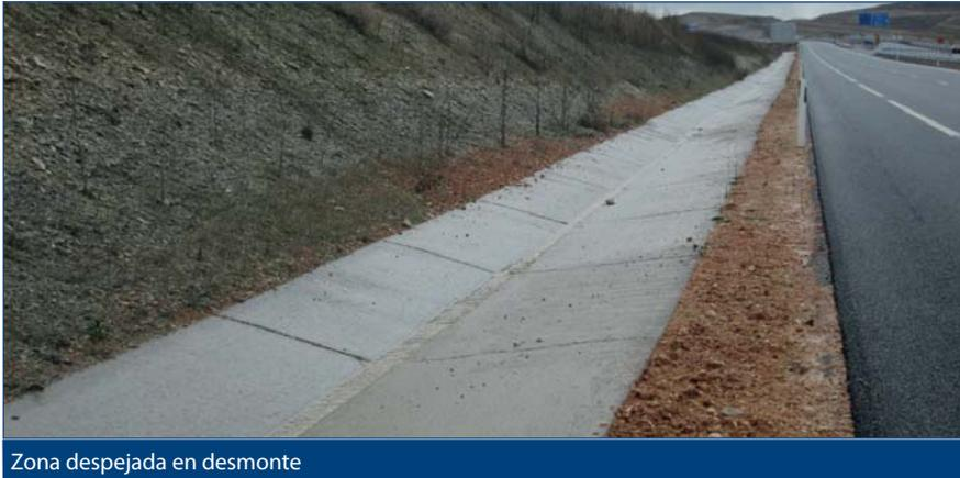
Las cunetas, salvo que tengan un diseño de "seguridad", pueden provocar el vuelco de los vehículos que se salen de la calzada hacia las mismas.
