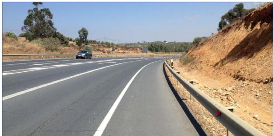
Cuneta y talud de desmonte protegidos con barrera de seguridad
