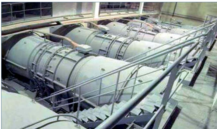
Figura 10. Ventiladores en caverna. Túnel de Somport
