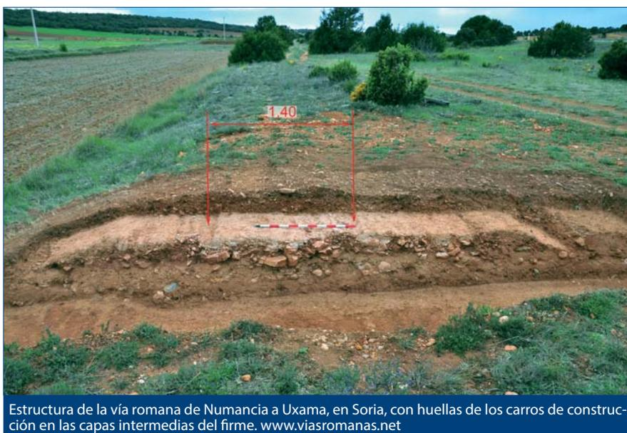
Estructura de la vía romana de Numancia a Uxama, en Soria, con huellas de los carros de construcción en las capas intermedias del firme. [www.viasromanas.net](http://www.viasromanas.net)
