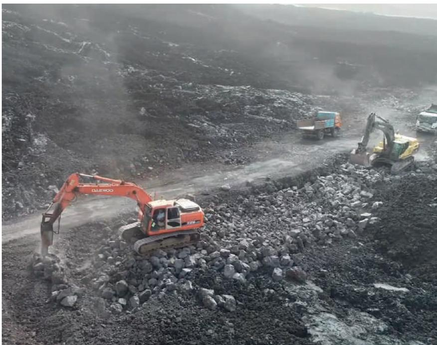
Figura 11. Trabajos de excavación en lava
