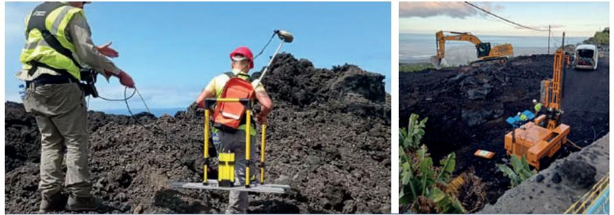
Figura 8. Trabajos de reconocimiento geotécnico
