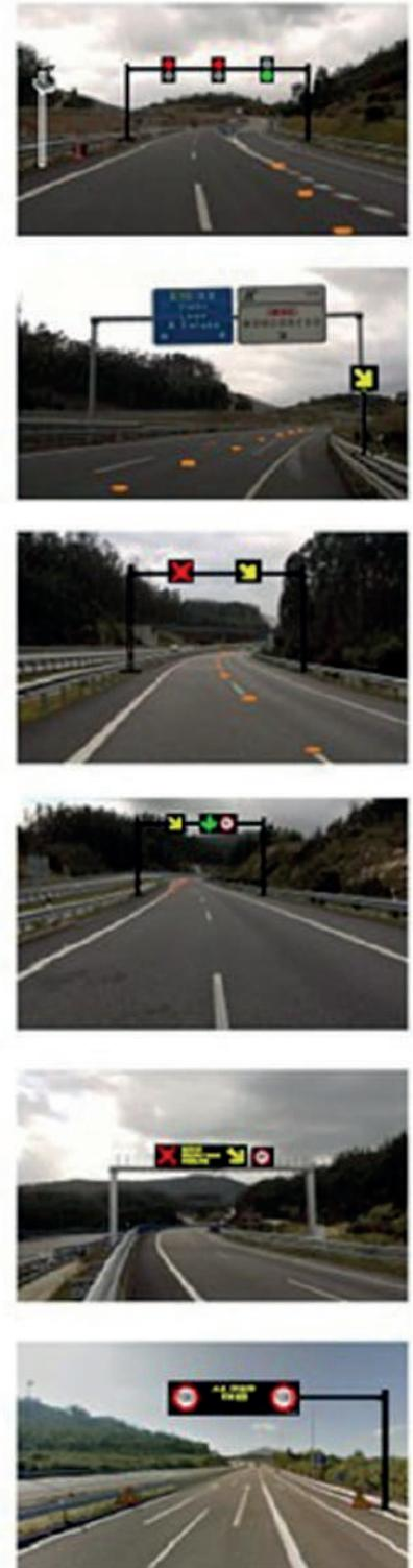
Figura 6. Detalle del esquema del equipamiento instalado en el tramo afectado de la A-8 y su funcionamiento
