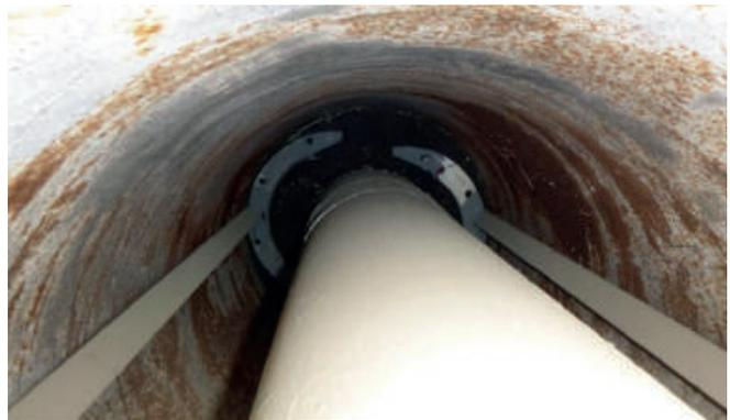
Figura 12. Recolocación anillo centrador. Anclaje Superior. Alpin .2019.
