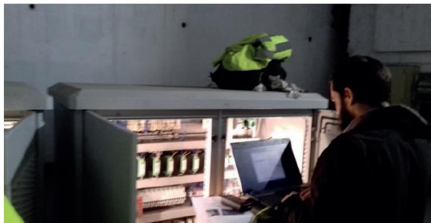
Figura 19. Revisión control sistema amortiguamiento dinámico. IMESAPI 2.021
