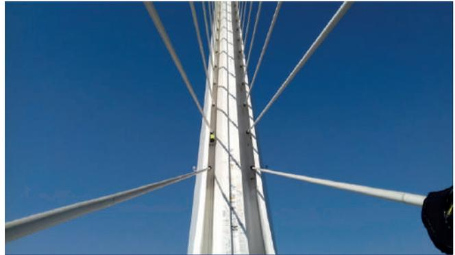
Figura 10. Cara interior de pilono: tubos encofrado paso tirantes. IMESAPI 2.019
