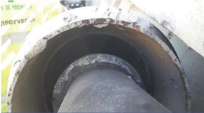
Figura 9. Interior tubo anclaje inferior. IMESAPI 2.019
