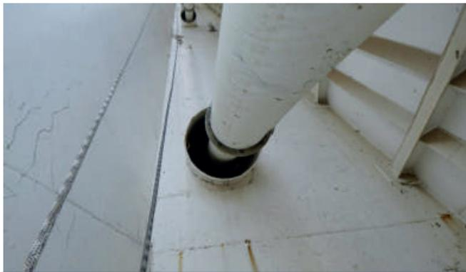
Figura 11. Tubos encofrado paso tirantes. Anclajes superiores. Alpin 2.019
