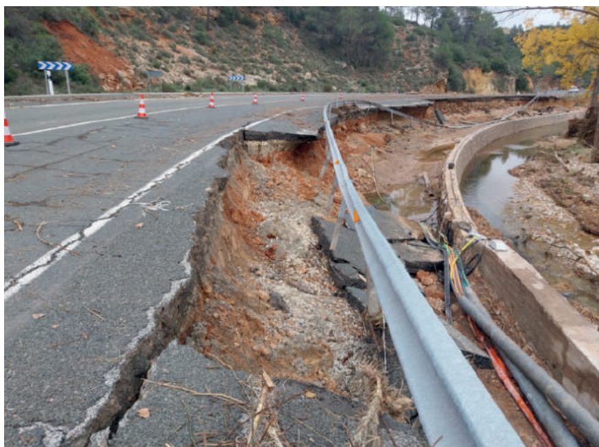
Tramo de carretera N-III paralelo al cauce del río Buñol (pp.kk. 294 y 297)
