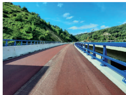
Figura 20. Aplicación de la capa de color rojo sobre la impermeabilización, como "aviso" durante futuros fresados
