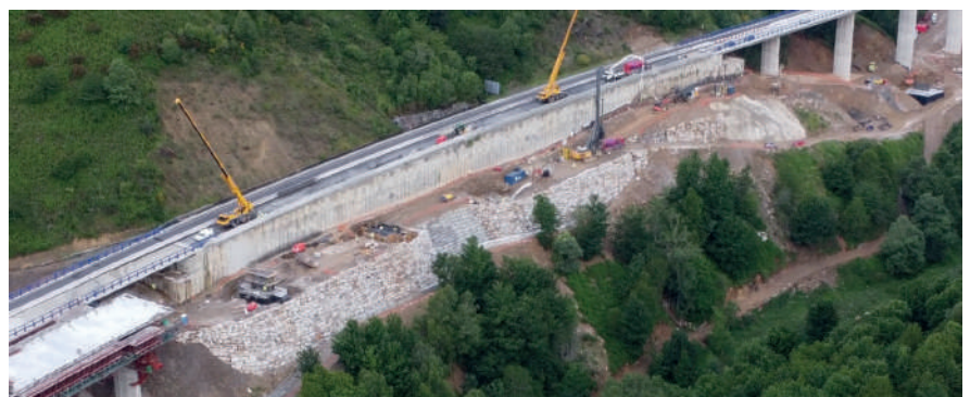
Figura 16. Vista general de las obras realizadas en la zona del muro de suelo reforzado.
