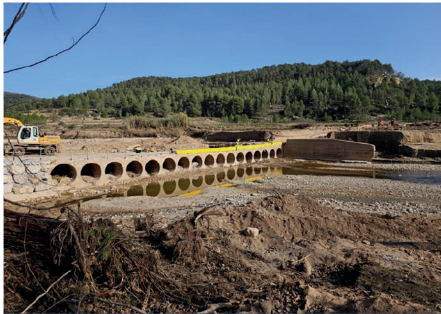
Estado actual trabajos de reconstrucción de la estructura sobre el río Magro en la CV-429
