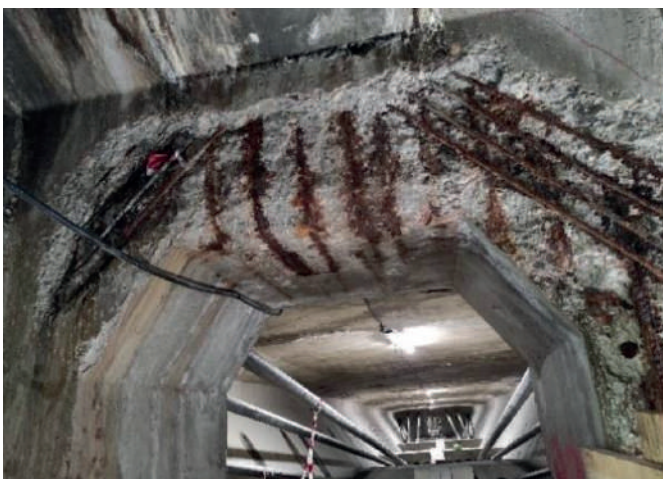
Figura 6. Daños de durabilidad en estructuras debidos al uso de sales fundentes.
