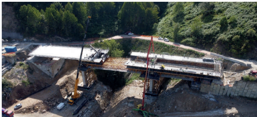
Figura 17. Ejecución del viaducto pequeño mediante cimbra porticada.
