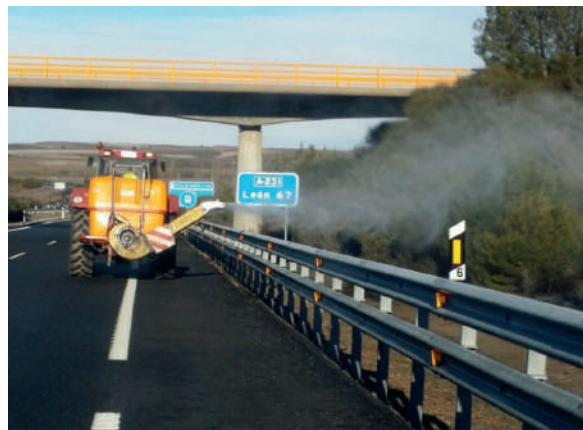
Figura 17. Extendido con medios mecánicos de productos disuasorios olorosos
