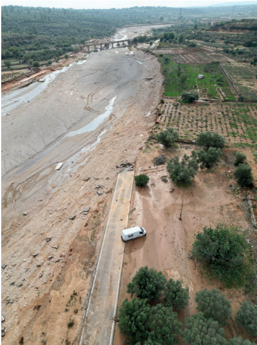
Afección a la carretera CV-383 de Cheste a Loriguilla
