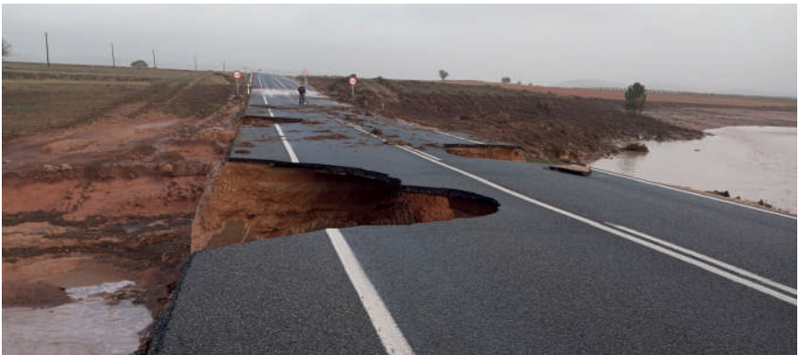
Paso de la N-330 sobre la Cañada de la Rinconada o del Asno, en Landete (p.k. 236)
