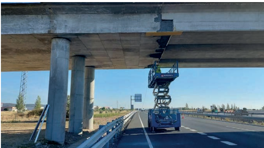
Figura 13. Reparación del apoyo a media madera
