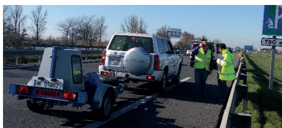
Figura 16. Ensayo con deflectómetro de impacto
