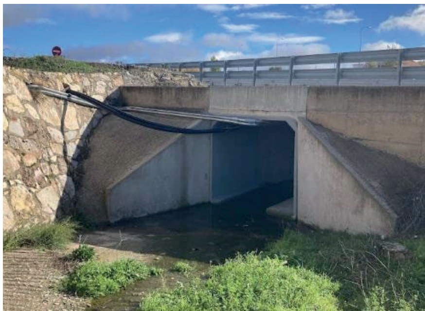
Figura 5. La Estrategia propone entre otras medidas la adaptación de estructuras y drenajes para facilitar el paso de especies. Foto: Manuel Oñorbe.
