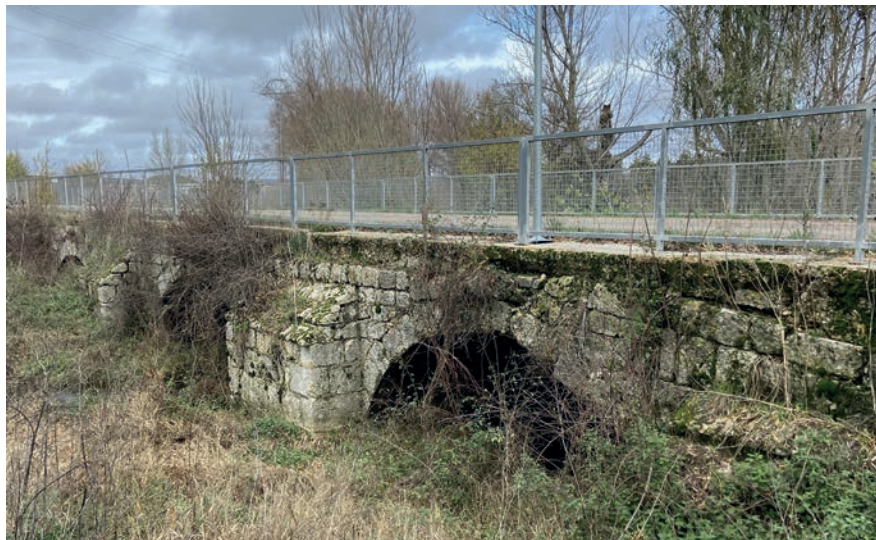
Figura 11. Puente de Vivar del Cid sobre el río Ubierna.
