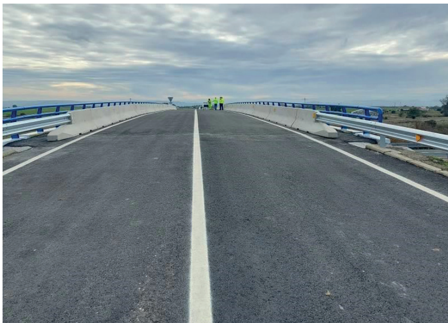
Figura 18. Vista superior del puente tras las actuaciones
