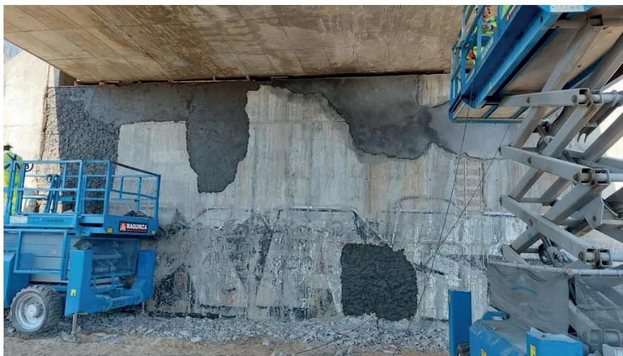
Figura 12. Reparación del paramento de un estribo
