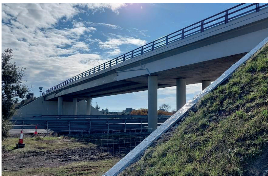
Figura 19. Alzado oeste del puente tras las actuaciones
